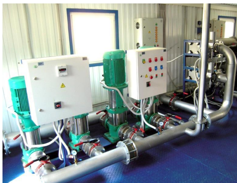
Рисунок 4 – Примерная комплектация насосной станции
